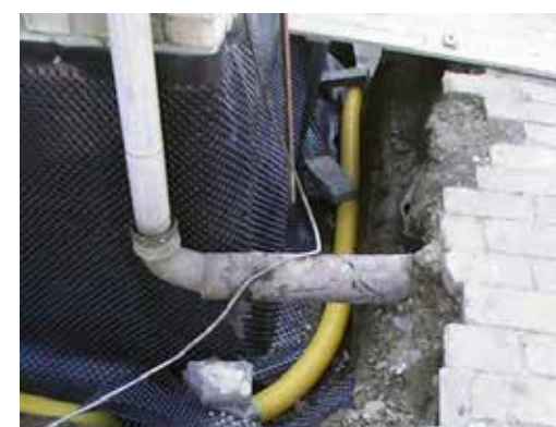
Drenážní trubka před zasypaním štěrskem.
