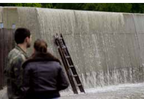
Protipovodňové zdi a valy neposkytují stoprocentní ochranu. Zed' v Hoříně, když přetekla za povodní v roce 2013.
