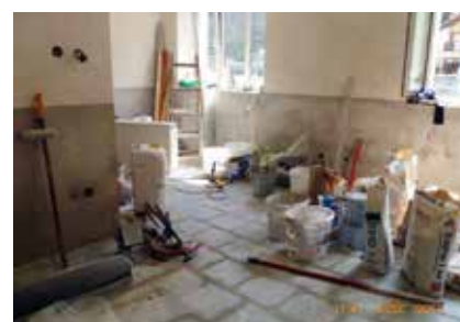
OPRAVY A OBNOVA
