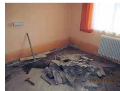
Parquetové a plovoucí podlahy je potřeba odstranit.
