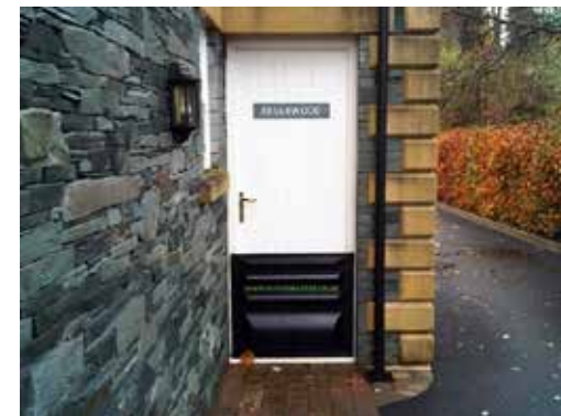
Demontovatelná zábrana na vstupní dveře zabránující vniknutí vody.
