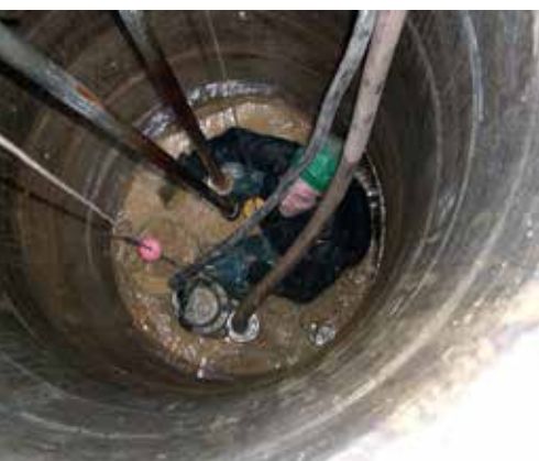
Studnu čistěte vždy za pomoci dalších osob.
