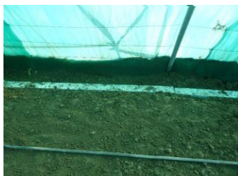
کاغذ کاک یا Styrofoam در داخل گودال کم عمق برای عایق نمودن
