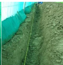
گودال کم عمق بخاطر گذاشتن کاغذ کاک یا Styrofoam
