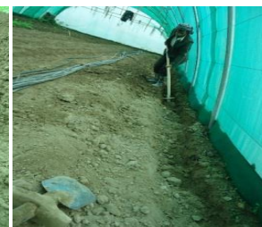
در داخل گلخانه برای عایق یک گودال کم عمق حفر نمائید
