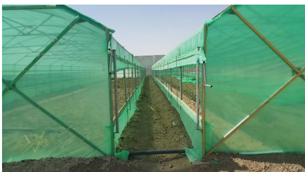
دریچه تهویه غیر فعال با رول دادن پلاستیک در جانب گلخانه - مزار شریف
