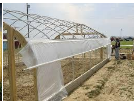
نصب دریچه تهویه جانبی غیر فعال رول دادن پلاستیک در تونل
