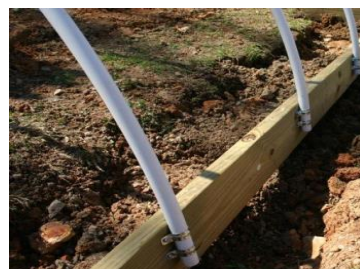
تونل چوکات بندی شده از پایپ پی وی سی
