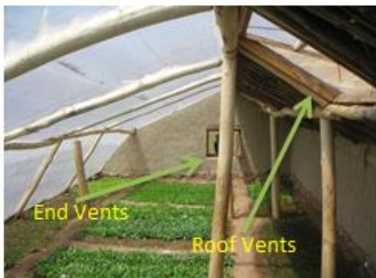
دریچه های سقفی و اخیر گلخانه در گلخانه با دیوار گلی
