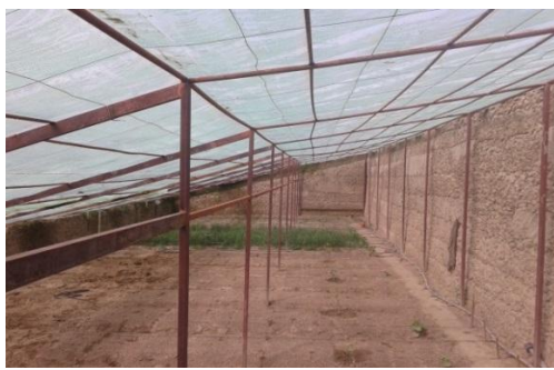
گلخانه با دیوار های جانبی و چوکات بندی فلزی
