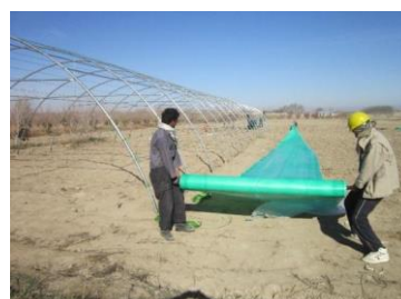
پوشش چوکات فلزی با پلاستیک
