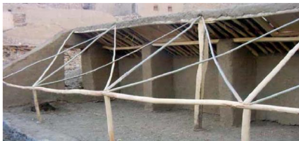
گلخانه ای که سمت، دیوار آن باید بطرف شمال و سمت که با پلاستیک پوش می‌گردد بطرف جنوب باشد تا از نور آفتاب بیشتر مستفید شود
