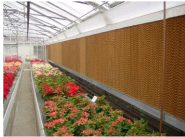
د سرونلو تبخير کونکی پد چې د تهويي د کرکي په داخل کي نصب شوی دی
