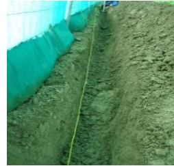
د شنی خونې د ننه د لږې ژورې کڼدې ایستل د کاغذ یا Styrofoam د ایښودلو لپاره
