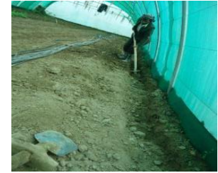
لږه ژوره کڼده د عایق فم یا بل شي د ایښودلو لپاره چمتو ده
