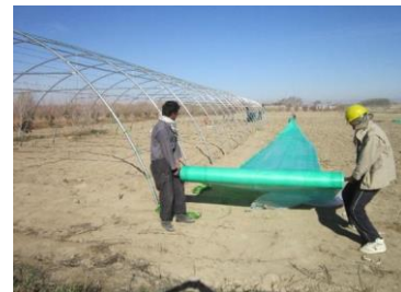
د فلزي اسکليت پوښل د پلاستيک پواسطه
