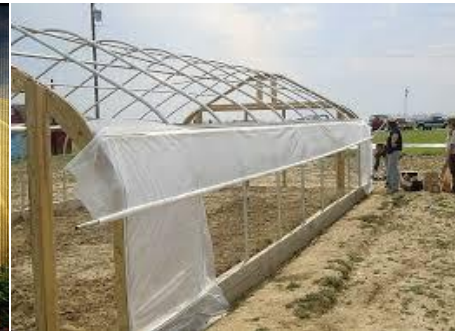
د ځنگونو د پلاستيکونو تاوول د تهويي لپاره
